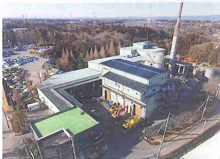
㈱カツタのリサイクル施設
