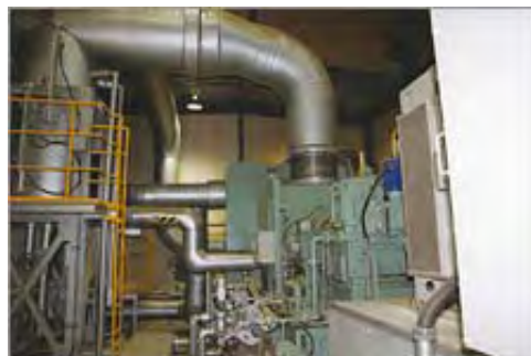
蒸気タービン。ここで蒸気を利用して発電機を駆動します。
